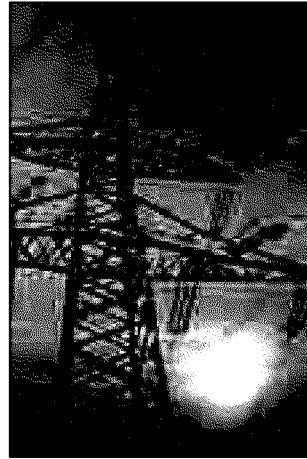
Un pilone elettrico
